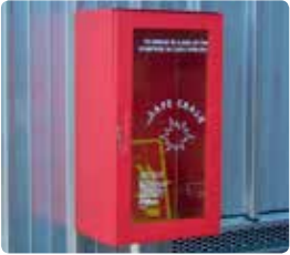
Armario para extintor
