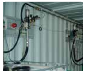
Sistema de bombas para el transvase de líquidos peligrosos
