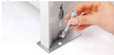
Para la fijación al suelo se debe usar tornillos con tracción mínima (incluido el factor de seguridad) de 4,3 Kn.
